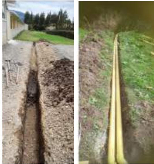
Imagen Nro. 64 y 65. Mantenimiento y arreglo de caja de aguas lluvias
