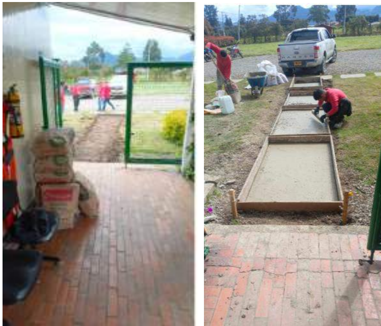
Imagen Nro. 62 Y 63. adecuación de accesos principales
